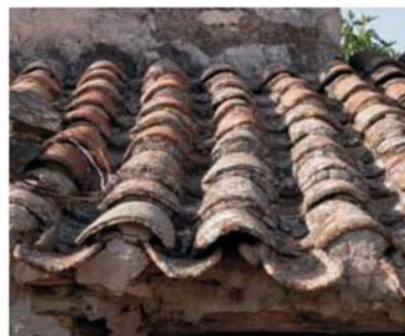
Soluzione di gronda elementare con aggetto semplice dei coppi-canale a Is Cattas.
